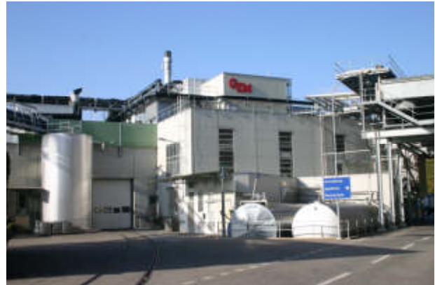
Nach der Seuchenmeldung werden die nötigen Schritte von Seiten GZM - Betrieb und Logistik – eingeleitet
