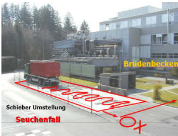
Desinfektionsplatz (-wann) im Seuchenfall – das Waschwasser wird im Seuchenfall im Betrieb dem Sterilisationsprozess zugeführt und nicht der ordentlichen Abwasserreinigung. Zu diesem Zweck wird durch einen Schieber der normale Abwasserstrom unterbrochen.
