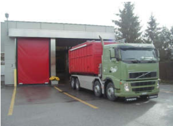
Annahmehalle mit Schnellaufrolltoren und permanenten Luftunterdruck, damit keine Seuchenerreger an die Aussenluft entweichen können.
