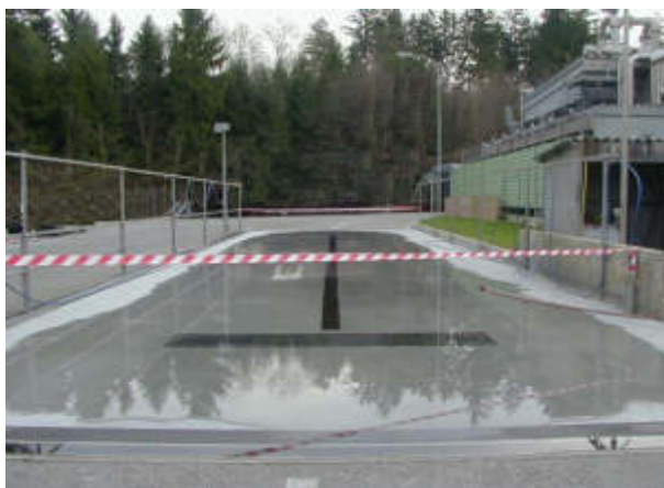
Der Camion passiert vor dem Verlassen des Betriebsgeländes die Desinfektionswanne.
