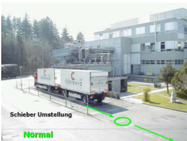
Reinigungsplatz, bzw. Desinfektionsplatz bei Normalbetrieb – das Waschwasser wird der ordentlichen Abwasserreinigung zugeführt.
