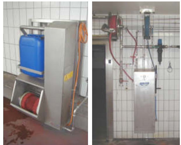
Die vorhandenen Reinigungsstellen werden mit Desinfektionsmittel ausgerüstet
