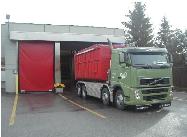
Annahmehalle mit Schnellaufrolltoren und permanenten Luftunterdruck
