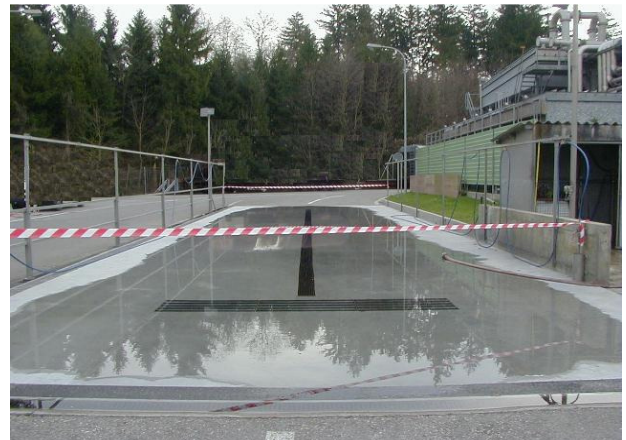
Der Camion passiert vor dem Verlassen des Betriebsgelände die Desinfektionswanne
